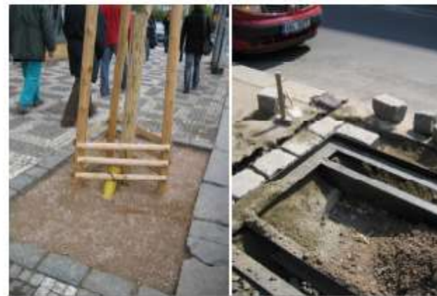
realizace otevřeného povrchu stromové mísy a instalace mříže
